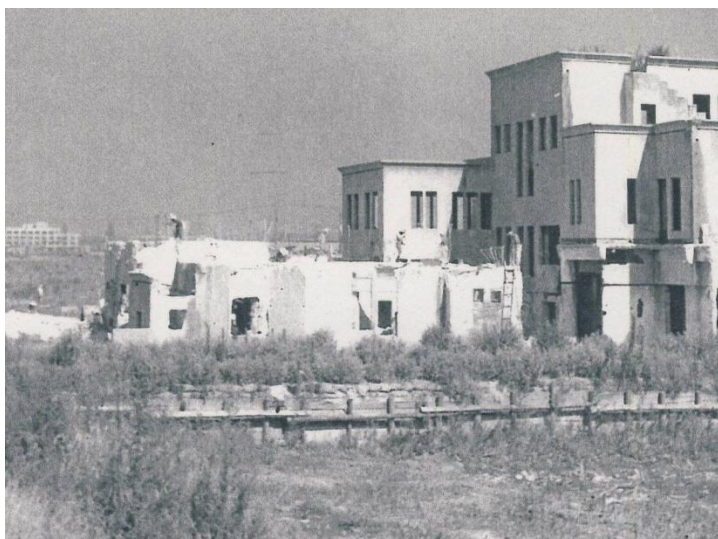
→解体中の戦災者住宅Ⅱ一九五一年春、田中町
